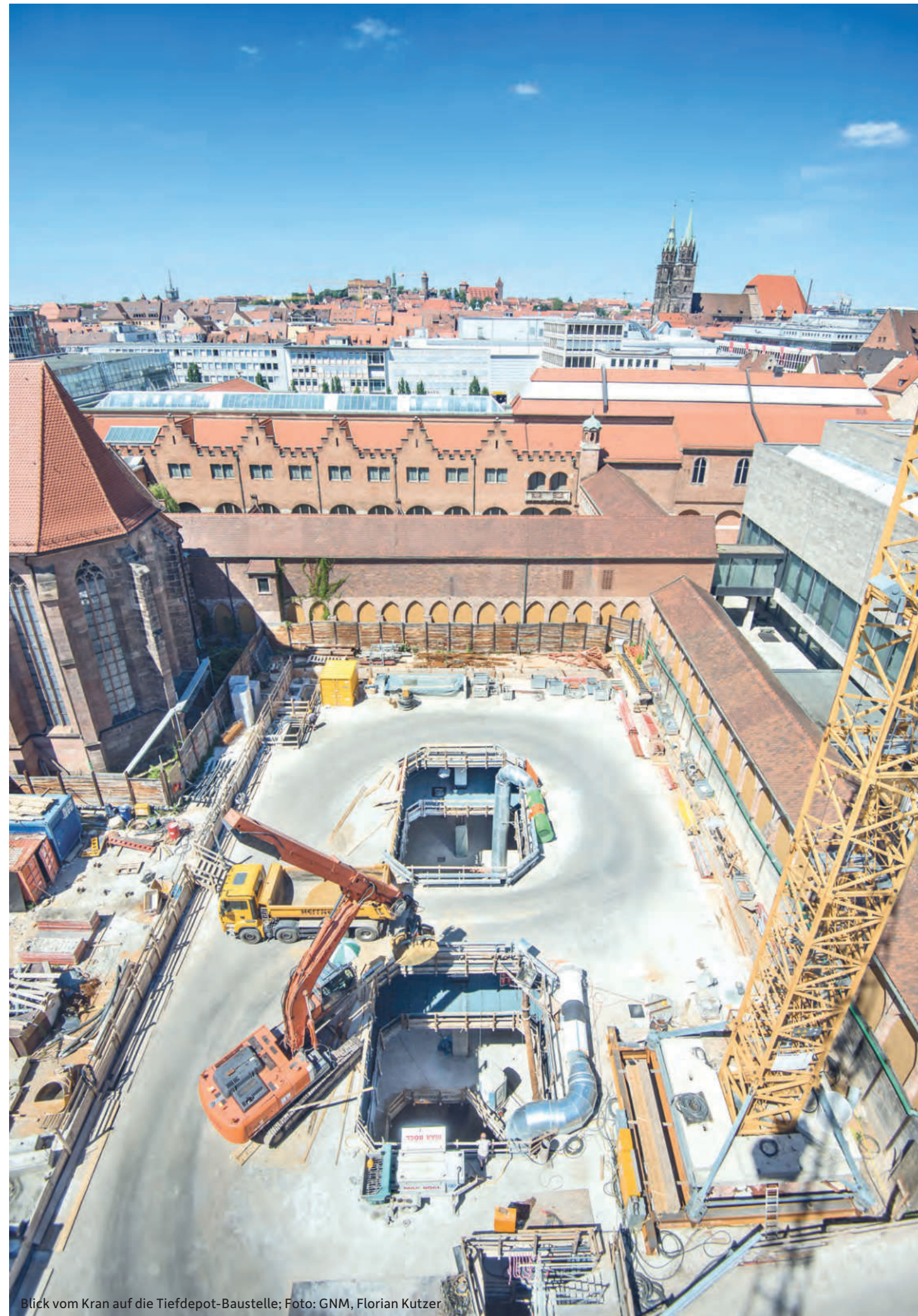
Blick vom Kran auf die Tiefdepot-Baustelle; Foto: GNM, Florian Kutzer
